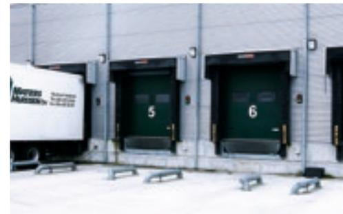
Durch die nahezu hermetische Abdichtung ist die 300-Serie besonders geeignet für die Beherrschung kritischer Klimazonen wie z.B. die Verladestellen bei Kühl- und Gefrierhallen. Das System ist universell anwendbar sowohl bei bestehenden als auch bei neuen Gebäuden und wird für alle Lkw-Größen angepasst gebaut. Hochwertiges Material – wie z.B. Kissen aus Cordura und Rahmen aus Isopanelen – tragen zu einer optisch ansprechenden Ansicht und einer langen Lebensdauer bei.
