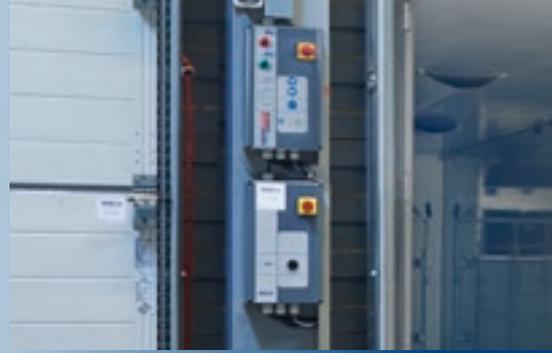
Das Bedienfeld hat Folientasten und ist mit anderen Docksystemen wie zum Beispiel Überladebrücken und/oder Rolltoren gekoppelt. Hierdurch ist eine kombinierte Sicherheitschaltung möglich. Dies bedeutet, dass der Lkw automatisch blockiert wird, bis die Überladebrücke in ihre Ruhestellung zurückgekehrt ist.
