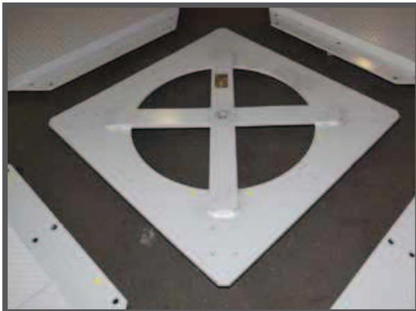
Die Anschlussstruktur wird durch ein Kreuzelement gefestigt, das am oberen Teil angeschweißt ist.
