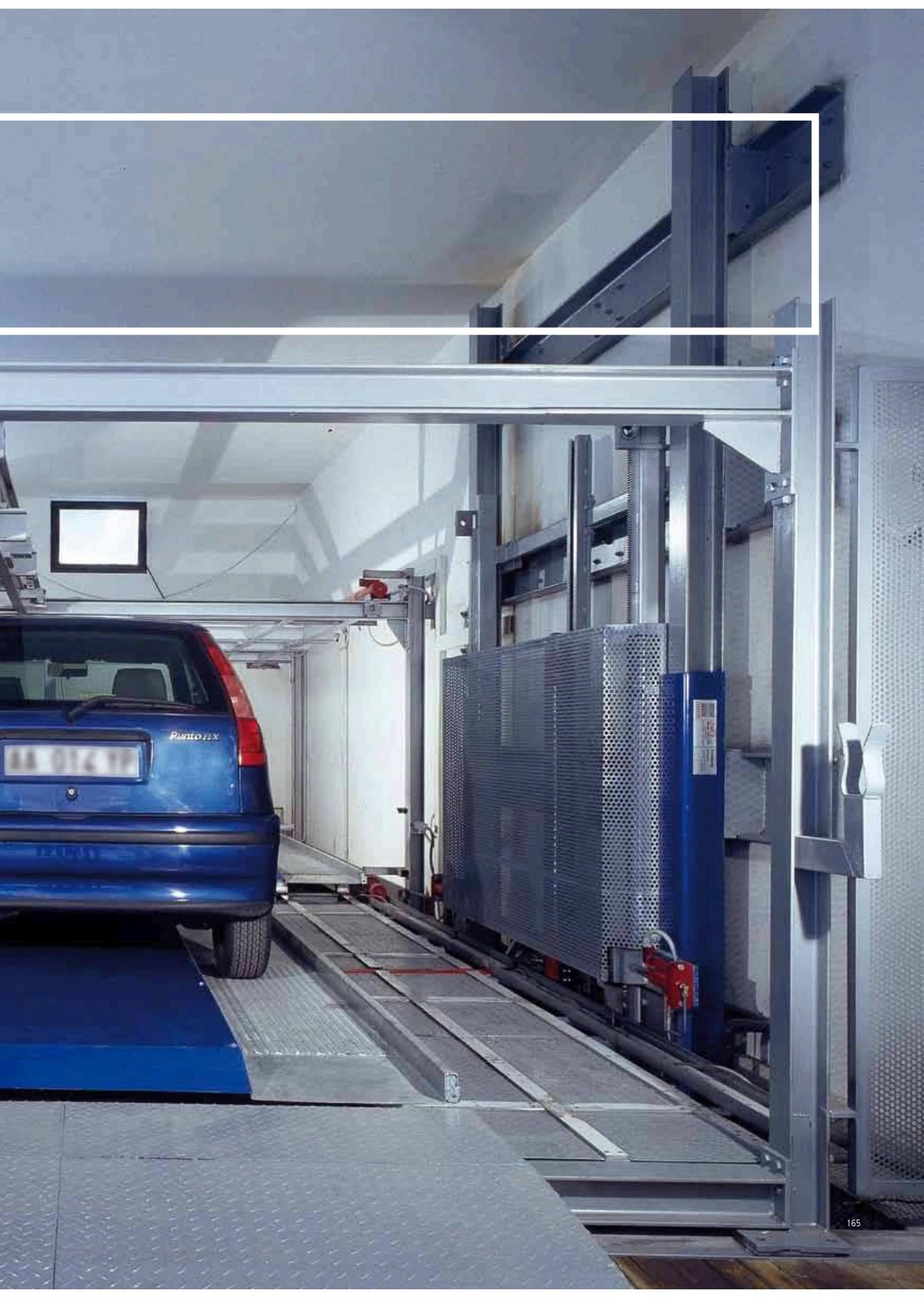
Tecnopark ist ein automatisiertes Parksystem mit hoher Lagerungsintensität, das es ermöglicht, Bereiche unterschiedlicher Formen auszunutzen wie Höfe, ungebräuchliche Garagen oder Kellergeschosse, die in Altstädten positioniert sind.
