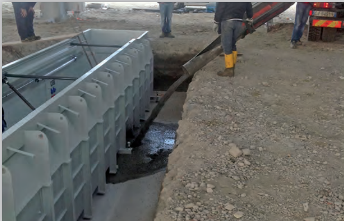
Fase 3: riempimento dello scavo con magrone solo sotto culatta fossa , per eliminare sacche d'aria e compattare il cassero con la platea madre.
