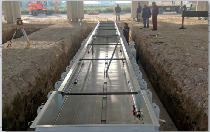
Fase 2: Posizionamento della fossa con allineamento a filo e a laser Stage 2: Positioning of the pit with a flush mounting system and laser finish 2 Phase: Positionierung der Gruppe mit Satt- und Laser-Ausrichtung
