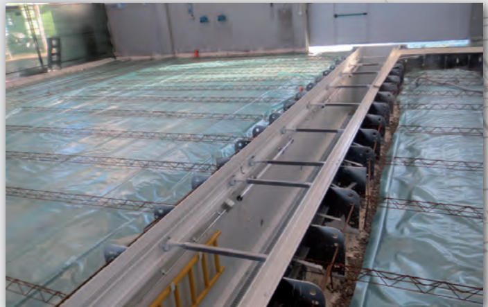
Fase 4: riempimento con sabbia o materiale di recupero e successivamente si procede a stendere la rete per gettare la pavimentazione industriale ed annegare la fossa.
